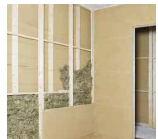
Trockenbauplatte aus Lehm zum Beplanken von Holz- und Metallständerkonstruktionen von Innenwänden, Vorsatzschalen, Decken- und Dachflächen. Die Lehmplatte schwer bringt viel Lehm ins Haus, mit allen positiven Auswirkungen für das Raumklima, besonders in thermischer Hinsicht. Sie ist mit der Handkreissäge zu schneiden. Die Lehmplatte D 22 erlaubt für Wände ein weites Trockenbau-Unterkonstruktionsraster von 62,5 cm.
