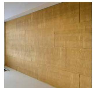
Trockenbauplatte aus Lehm und Schilf zum Beplanken von Holz- und Metallständerkonstruktionen von Innenwänden, Vorsatzschalen, Decken- und Dachflächen. Die Claytec-Lehmbauplatte ist Trockenbauplatte und Lehmputz in Einem. Sie entstand aus handwerklicher Erfahrung und ist seit 20 Jahren am Markt. Mit einer Rohdichte von 700 kg/m<sup>3</sup> bietet sie Lehm- und Schilfmasse und ist dabei gut zu verarbeiten.
