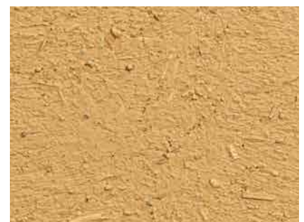
Struktur einer gut vorbereiteten Fläche aus Lehm-Unterputz
