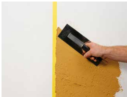
Auftrag der ersten Farbe an das Klebeband
