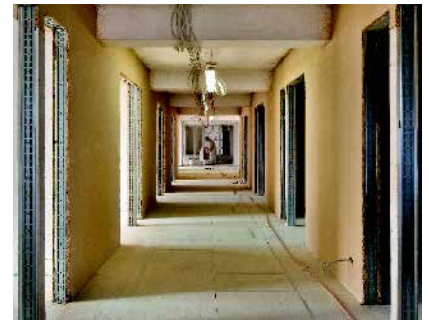
Lehm-Dünnlagen Beschichtung beim BV UN-Campus, Bonn
