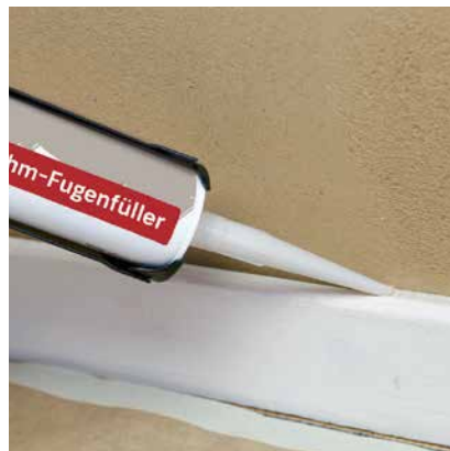
Fugenfüllung mit natur-weiß an einer Sockelleiste
