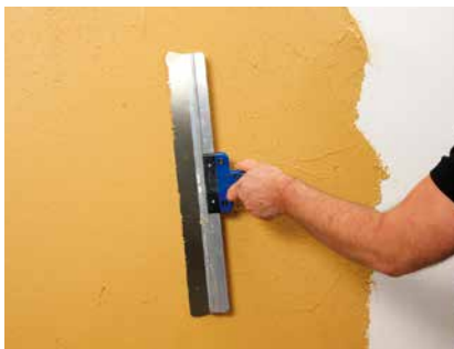
Abziehen mit dem Flächenspachtel
