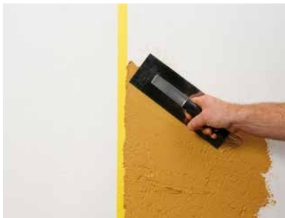
Auftrag der ersten Farbe an das Klebeband
