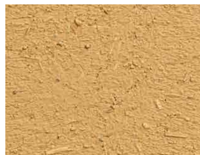
Struktur einer gut vorbereiteten Fläche aus Lehm-Unterputz
