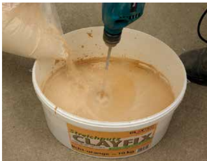
Einrühren des Eimerinhalts in Wasser
