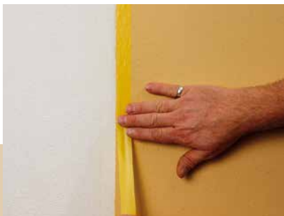
Erneutes Abkleben nach Trocknung
