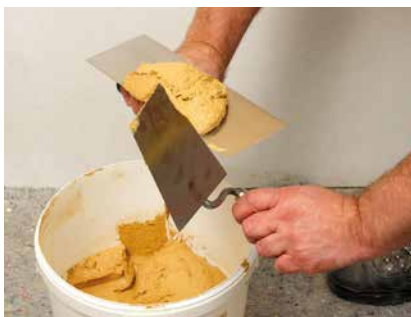
Entnehmen des Mörtels
