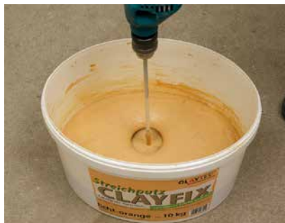
Nach 30 Minuten Quellzeit gut durchrühren
