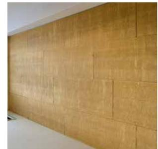
Trockenbauplatte aus Lehm und Schilf zum Beplanken von Holz- und Metallständerkonstruktionen von Innenwänden, Vorsatzschalen, Decken- und Dachflächen. Die Claytec-Lehmbauplatte ist Trockenbauplatte und Lehmputz in Einem. Sie entstand aus handwerklicher Erfahrung und ist seit 20 Jahren am Markt. Mit einer Rohdichte von 700 kg/m<sup>3</sup> bietet sie Lehmmasse und ist dabei gut zu verarbeiten.
