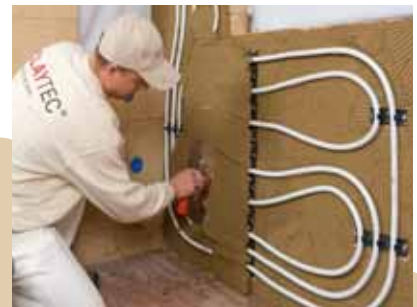
Der Unterputz wird über die Rohrscheitel abgezogen
