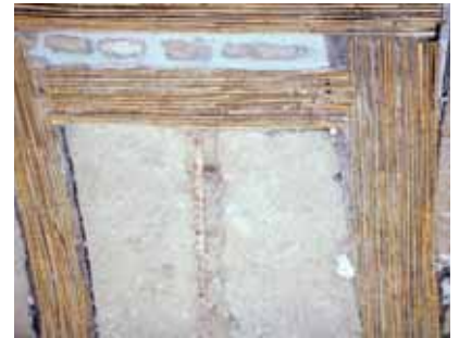
Rohrgewebe St70 auf Holzbalken einer Fachwerkwand
