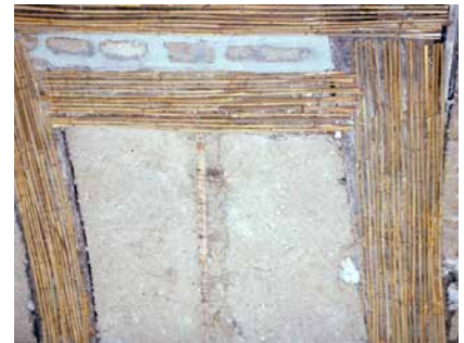
Rohrgewebe St70 auf Holzbalken einer Fachwerkwand
