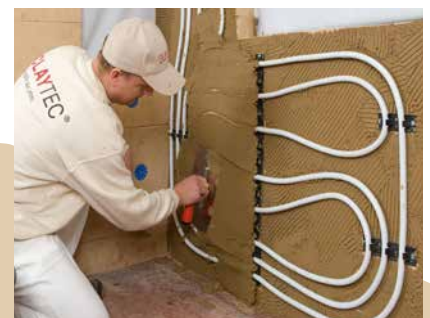
Der Unterputz wird über die Rohrscheitel abgezogen
