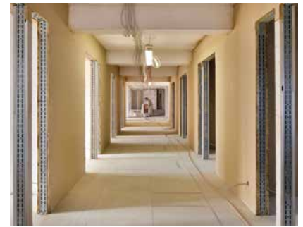
Lehm-Dünnlagen Beschichtung beim BV UN-Campus, Bonn
